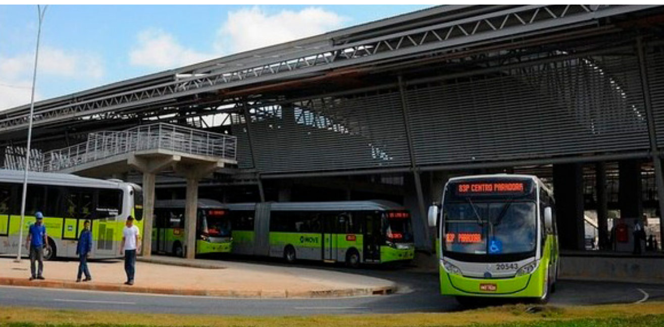
Figura 13. O terminal de integração São Gabriel em Belo Horizonte contava com uma série de problemas relacionados à infraestrutura, manutenção, operação e segurança. Em 2017 foi criado a Força-tarefa São Gabriel, um grupo formado por gestores e operadores do poder público e privado, além de agentes de segurança da Guarda Municipal e Polícia Militar, com o objetivo de prover soluções conjuntas e integradas para os problemas encontrados. O grupo passou a realizar então reuniões semanais para prover maior articulação entre estes atores e a estruturar os canais de recomendação. Além disso, o grupo considerou a participação da sociedade civil no desenvolvimento e monitoramentos das potenciais soluções encontradas. Fonte da Imagem: BHTrans
