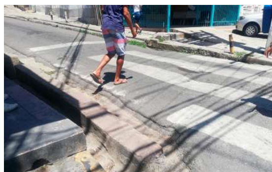
Figura 15. Apesar de contar com faixa de pedestres e com semáforo para veículos, a travessia presente no início da Estrada da Conceição teve a pontuação reduzida por contar com desníveis muito grandes entre a calçada e a travessia, não atendendo a critérios mínimos de acessibilidade universal
