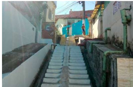
Figura 21. Escadaria da Rua Macau, numerada como escadaria 3
