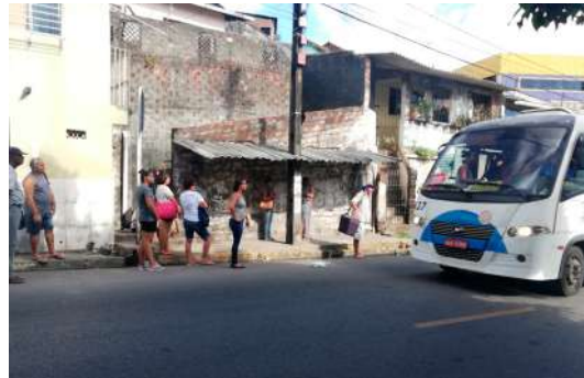
Figura 30. A ausência e a necessidade sentida pelos moradores a respeito da infraestrutura do ponto de ônibus localizado na Rua Córrego do Bartolomeu próximo a Rodinha, levou os mesmos a construir uma cobertura contra intempéries. Além disso, a largura insuficiente da calçada, faz com que os usuários também aguardem o ônibus no leito carroçável
