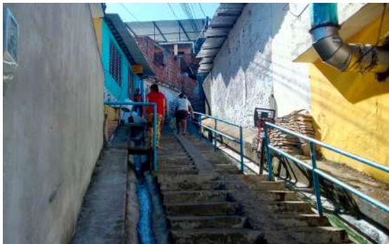
Figura 20. Escadaria da Rua Belamiro Henrique, numerada como escadaria 2
