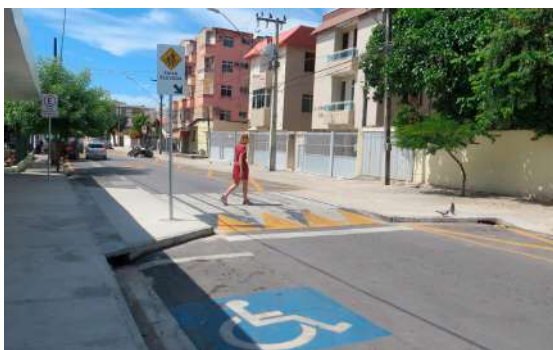
Figura 41. Travessia em nível presente em Fortaleza, com estrangulamento da via
