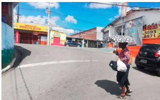
Figura 12. Interseção entre Rua Itacoatiara, a Estrada do Morro da Conceição e a Rua Praça da Conceição sem a presença de elementos para uma travessia segura
